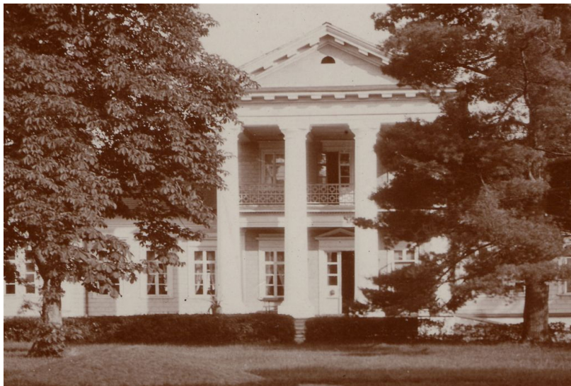
Dwór w Dereszewiczach zbudowany ok. 1828 r. (fotografia pochodzi z roku 1913). Na pierwszym piętrze między kolumnami (po lewej) okno pokoiku Jadwigi Kieniewiczówny, autorki reprodukowanych tu akwarel oraz portretu Feliksa Kieniewicza.
